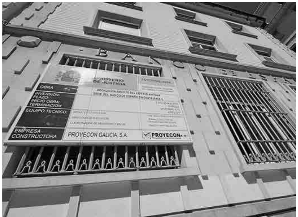
Las obras en el antiguo Banco de España no cumplen los plazos establecidos.
